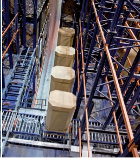
Depo koridorlarındaki konveyörler.
